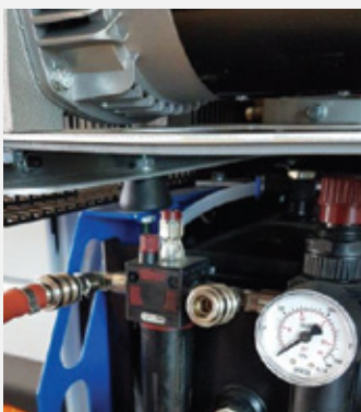
Single-phase generator (3,2 Kva)
